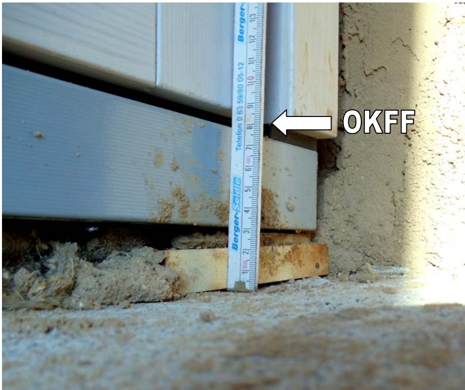
Der Anschluss des fertigen Fußbodens kann oberflächenbündig mit OK Rahmen erfolgen
